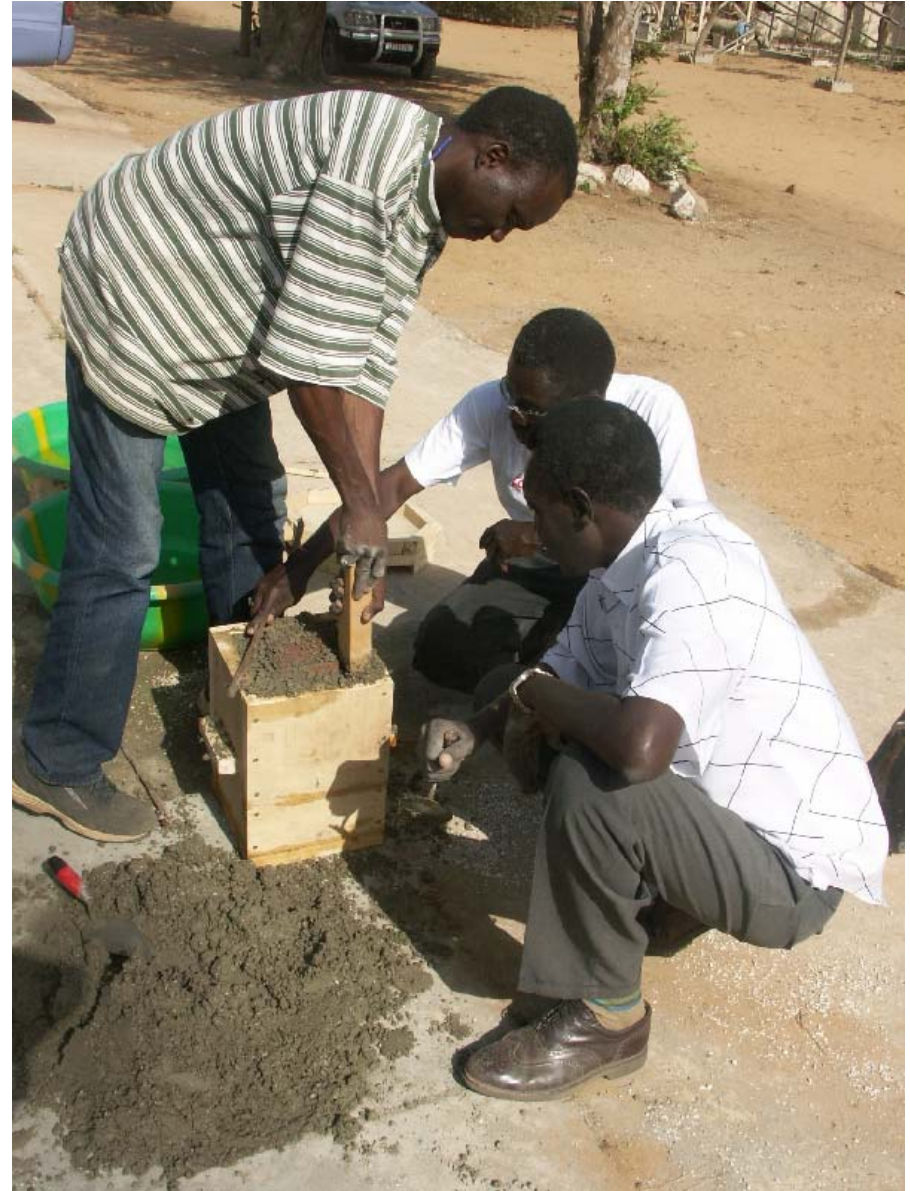
Illustration 10: L'épaissement du mélange à base de ciment
