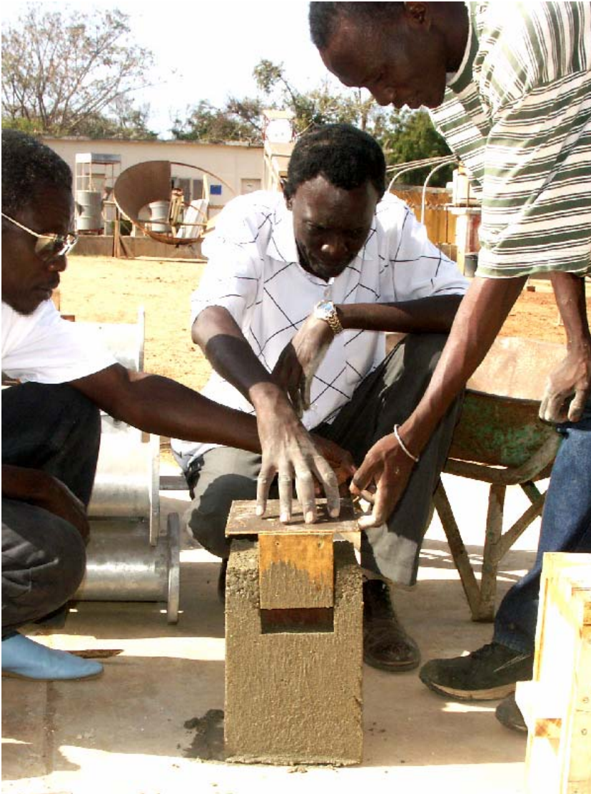
Illustration 11: L'extraction du moule intérieur conique ...
